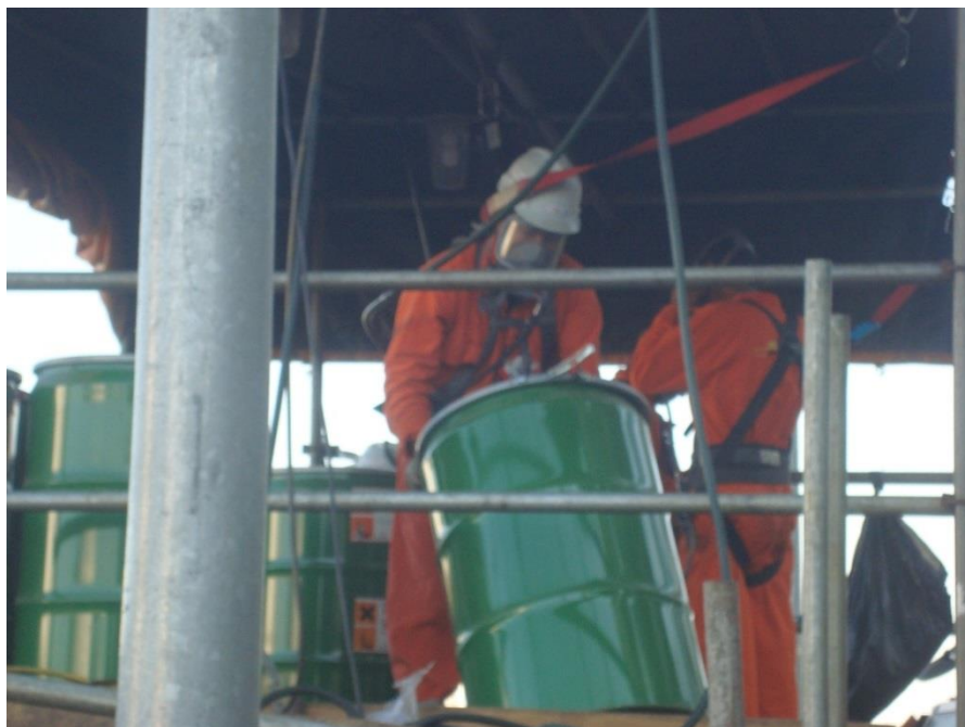
Figura 12 - Utilização de cintos e ponto de atracação acima da cabeça
